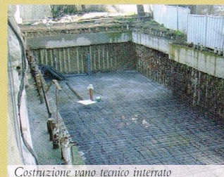
Costruzione vano tecnico interrato
